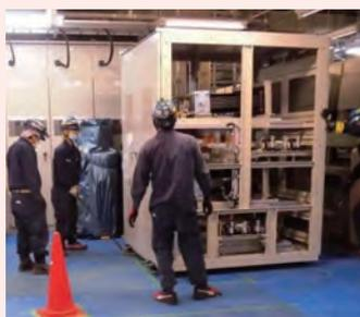
変電所設備更新(回生インバータ更新)
